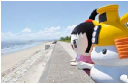
河芸地域から香良洲地域へ続く海岸堤防
