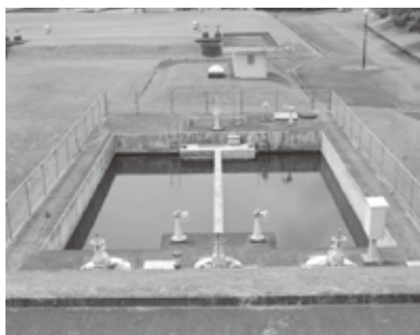
耐震補強工事を行う片田浄水場
