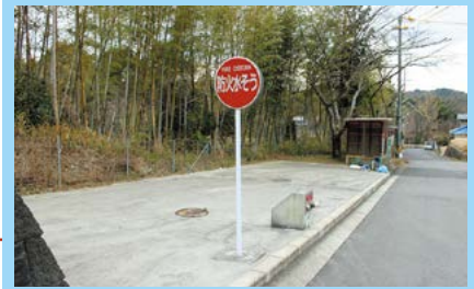
⑭家所耐震性防火水槽設置
