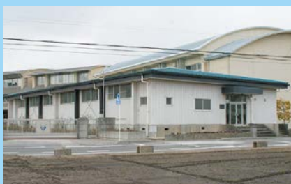
④ 芸濃武道場耐震補強、トイレ改修
