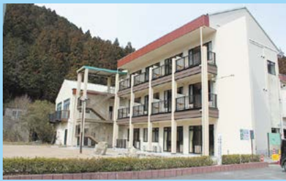
③ 錫杖湖水荘耐震補強
