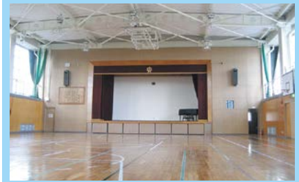
⑭ 明小学校屋内運動場耐震補強
