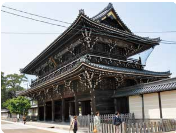
重要文化財 専修寺山門
