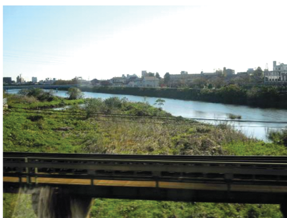
近鉄名古屋線（車窓から）
