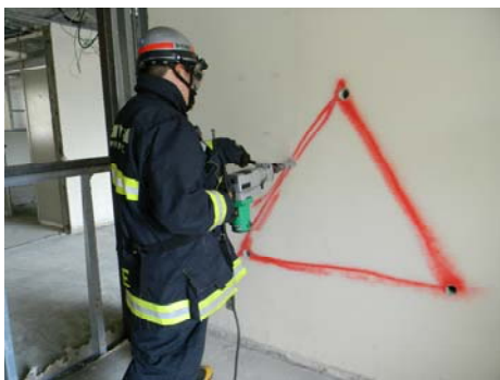
↑ドリルでコンクリート壁に穴をあける隊員
