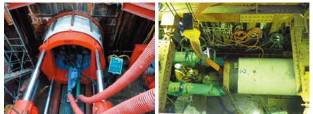
雨水幹線推進工事の様子
