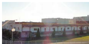
津市中央浄化センター (昭和52年供用開始) 平成28年度から耐震工事を実施中
