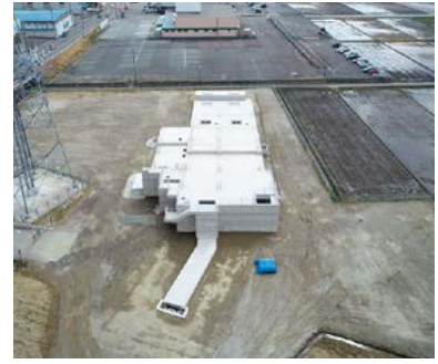
整備中の天神ポンプ場(3月18日)
