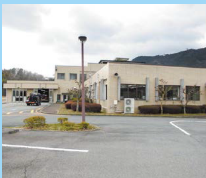
⑥ 安芸・津衛生センター施設設備改造
