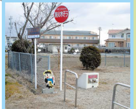
⑰ 耐震性防火水槽設置(曽根児童公園)
