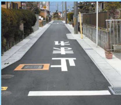
④ 市道側溝整備(清水地内)
