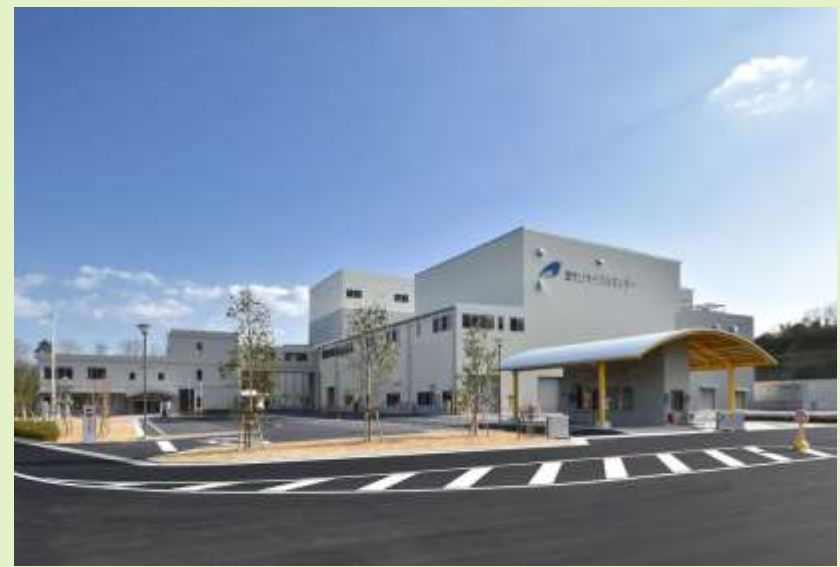
津市リサイクルセンター（片田田中町地内）
