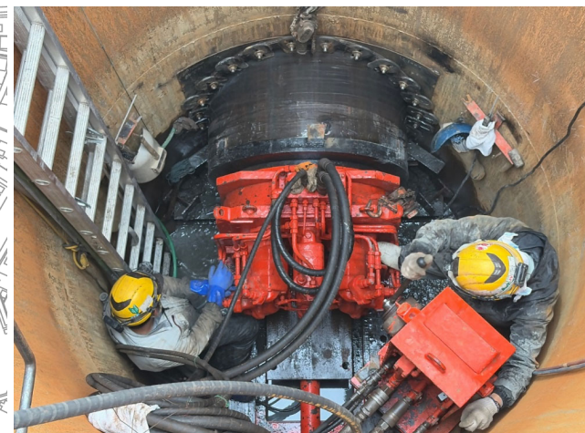
取水施工状況
