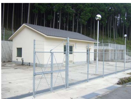
写真-10 中太郎生西簡易水道浄水場
