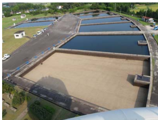
写真一5 緩速ろ過設備 (片田浄水場)
