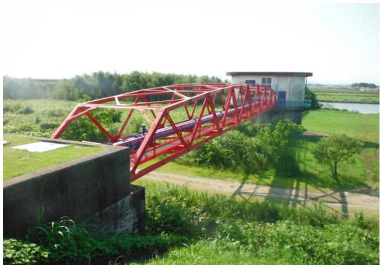
写真－12 三雲水源地
