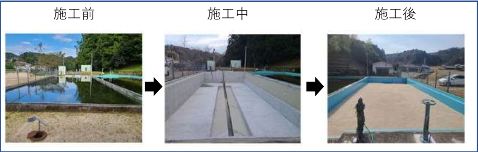
ろ過池における耐震化工事の流れ (久居別所浄水場)
