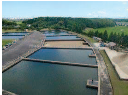
図 3.1 緩速ろ過池（片田浄水場）
