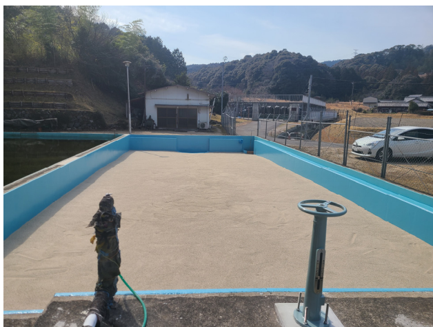
図 5.5 浄水場の耐震化（久居別所浄水場 2 号緩速ろ過池）
