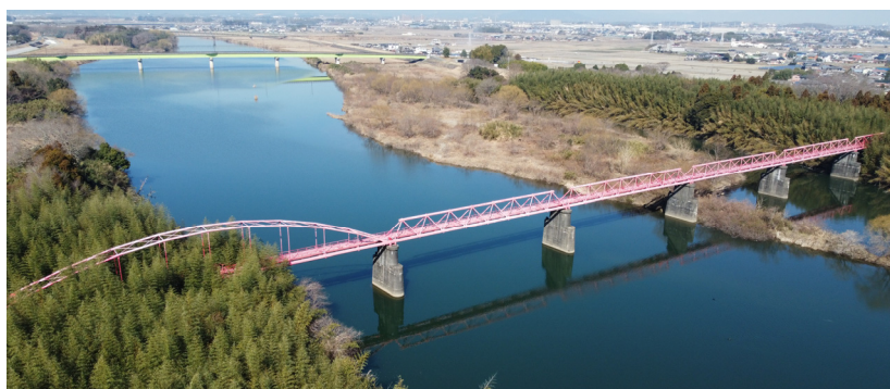
図 5.7 雲出川水管橋
