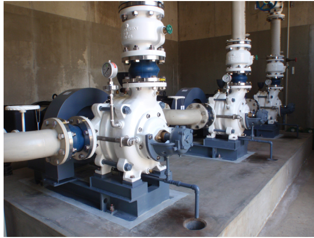
図 5.11 夢が丘ポンプ場送水ポンプ更新
