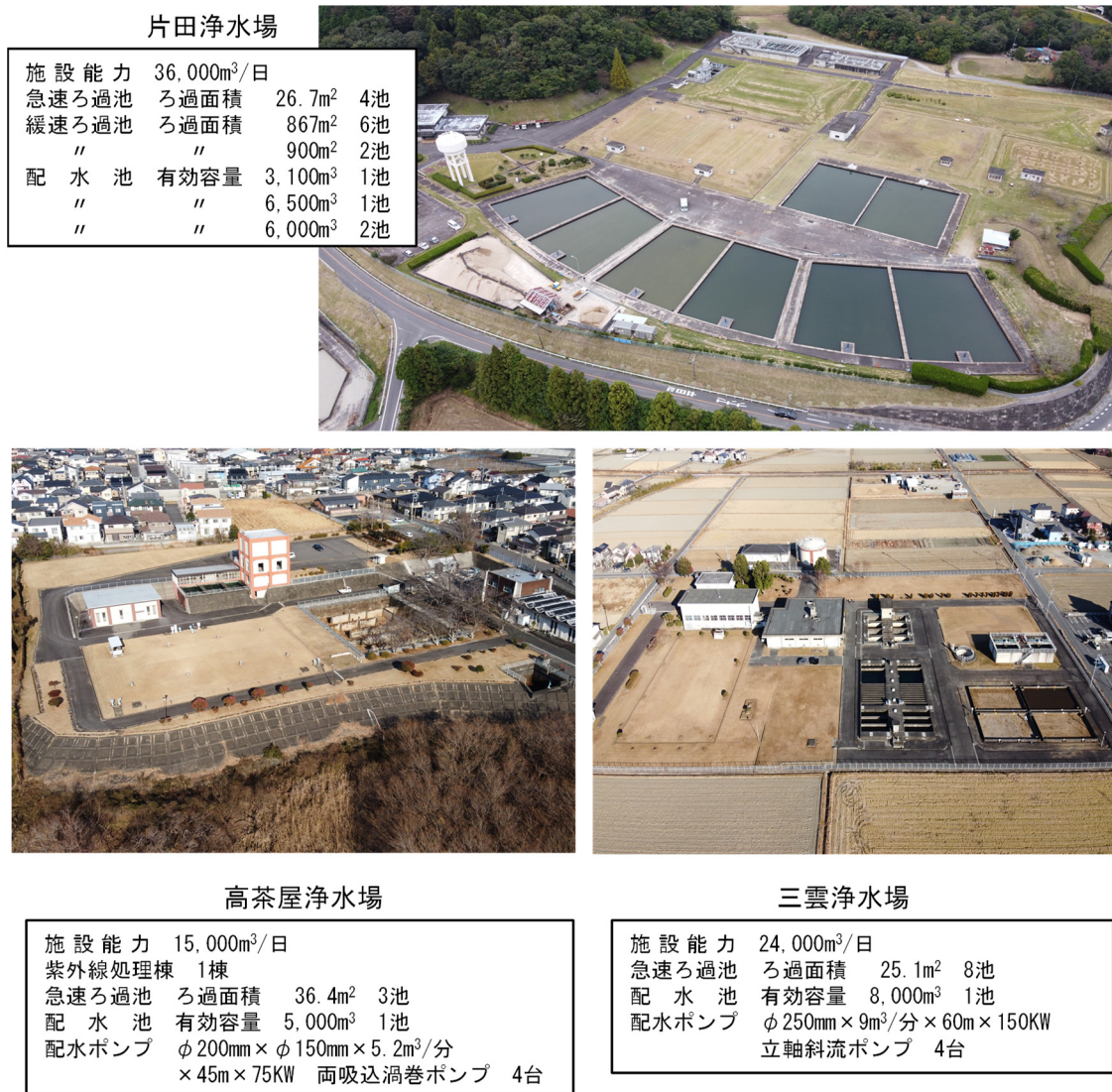
図 2.9 本市の主要な浄水場
