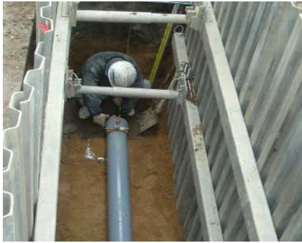
市街地における管布設工事の様子
