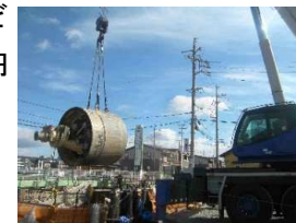
半田川田雨水幹線築造工事
