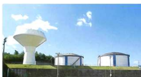
耐震補強を行う河辺配水池
