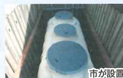
市が設置した浄化槽
