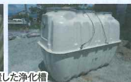
市が設置した浄化槽
