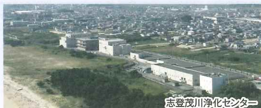
志登茂川浄化センター
