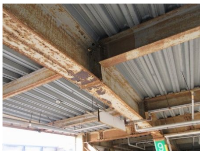
アスト駐車場 支柱
