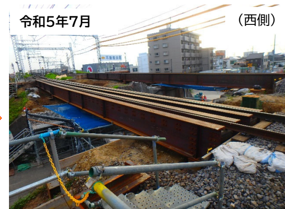
仮桁設置状況
