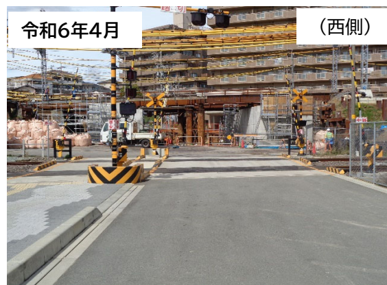
近鉄架道橋 新橋台設置作業
