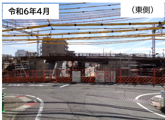
近鉄架道橋 新橋台設置作業
