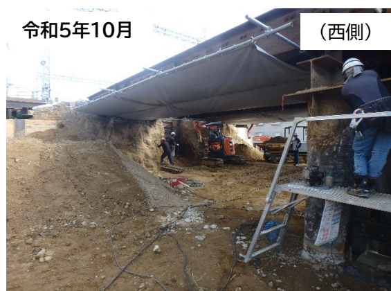
掘削等作業状況
