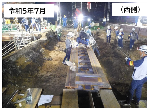
近鉄架道橋 仮桁設置作業
