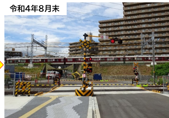
新踏切道の工事状況
