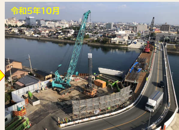
新橋台 場所打ち杭作業
