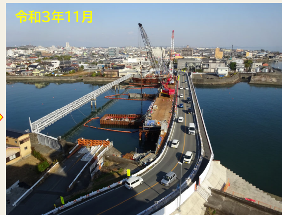
既設橋脚撤去作業
