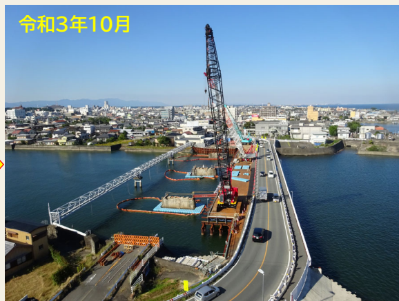
既設橋脚撤去作業
