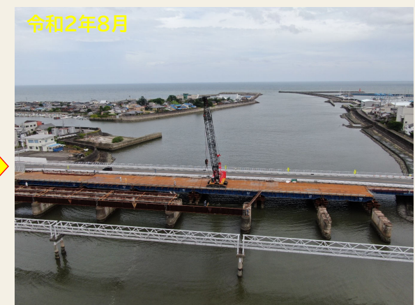
既設上部工撤去作業中
