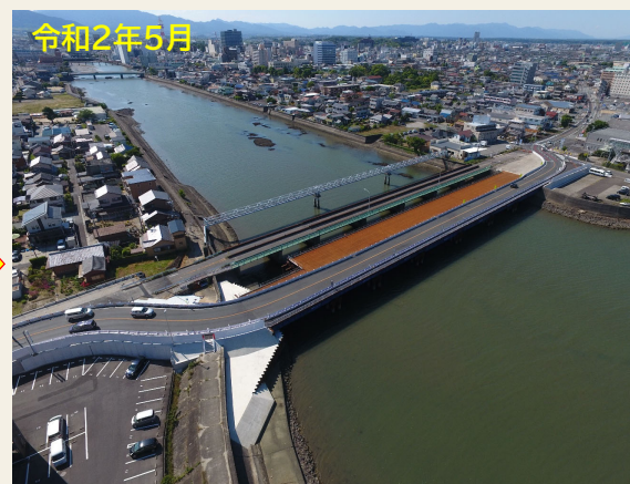
迂回路仮橋・工事用仮橋工事完了
