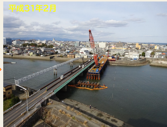
迂回路仮橋・工事用仮橋設置作業
