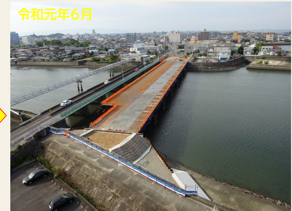
迂回路仮橋・工事用仮橋設置作業
