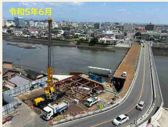
旧橋台 撤去作業
