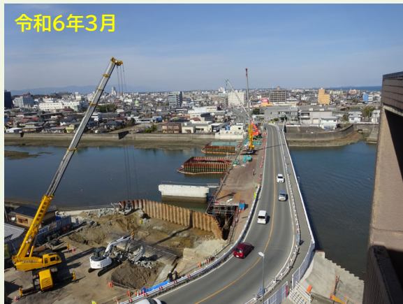
新橋台、橋脚の構築及び護岸復旧
