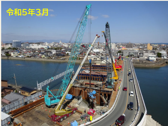
河川内二重締切作業
