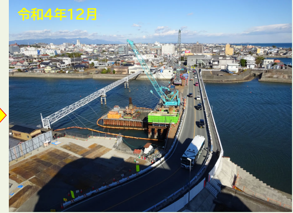
新橋脚 場所打ち杭作業
