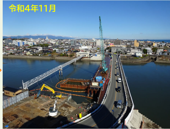
河川内締切作業
