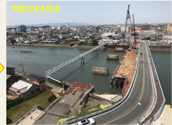
既設橋脚撤去完了
