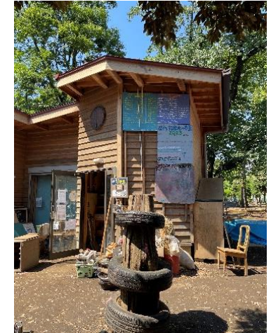
【屋外トイレ付活動小屋】
