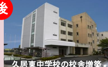
久居東中学校の校舎増築
