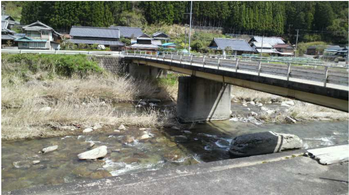
中津橋右岸（県道側）から撮影
