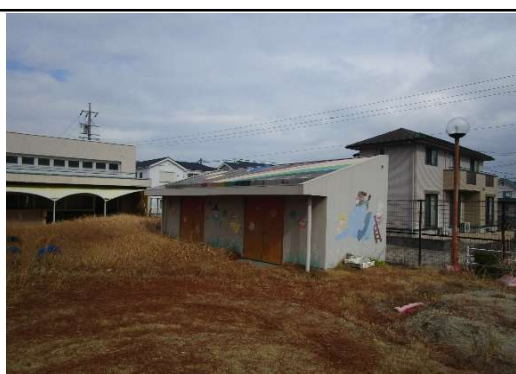
5 付属建物と屋外照明
