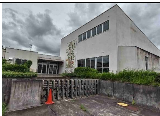
3 物件北側から建物入口を望む
