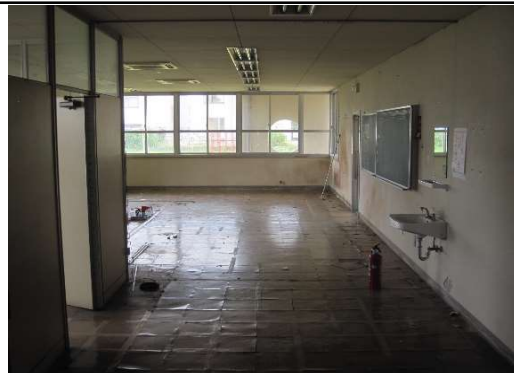
10 旧職員室の状況
