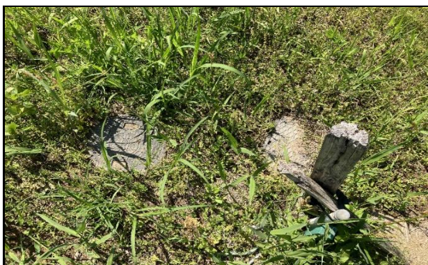
3 供給施設の状況
