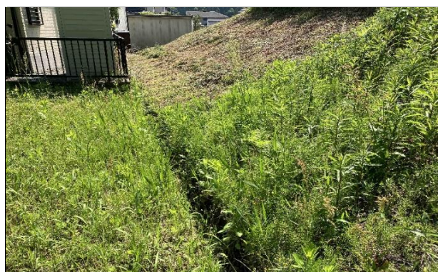
8 敷地奥の状況
