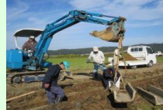
コンクリート水路の更新
