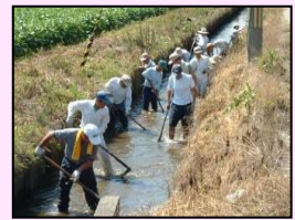
水路の泥上げ
