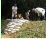
漏水箇所の補修
