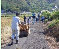
未舗装農道の舗装
