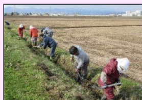
水路の泥上げ
