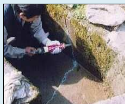
ひび割れの補修
