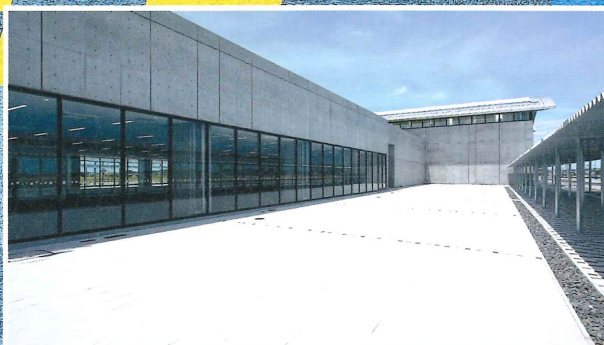
屋外展示場 キッチンカー、物販も可能な展示場。上水道、排水設備、コンセントを完備しています。
