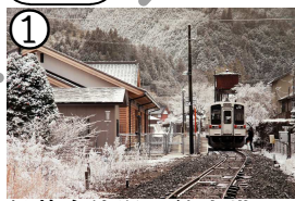
伊勢奥津駅SL給水塔
