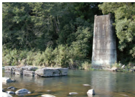
雲出川に残る橋脚
