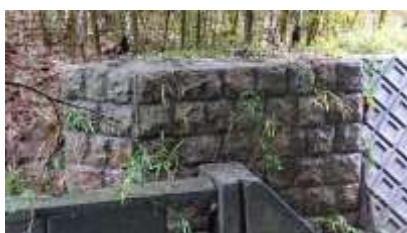
相川に架かる、中勢鉄道の橋台跡が、両側に綺麗に残っています。
