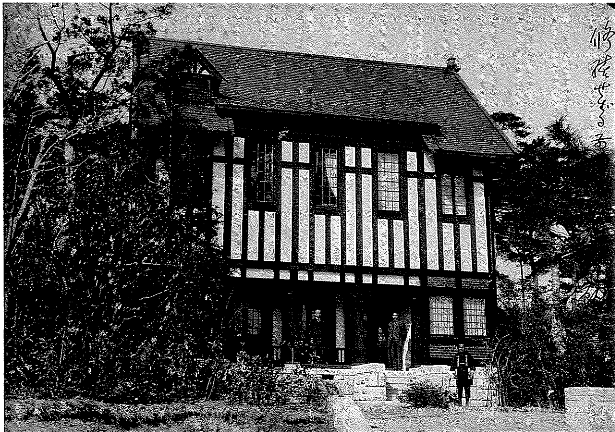
追資料14 注記「修繕せざる前の千才洋館」
