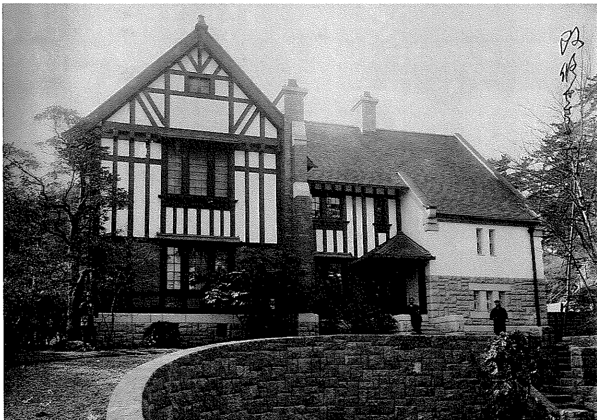
追資料13 注記「改修せざる前の千才山荘正宅」
