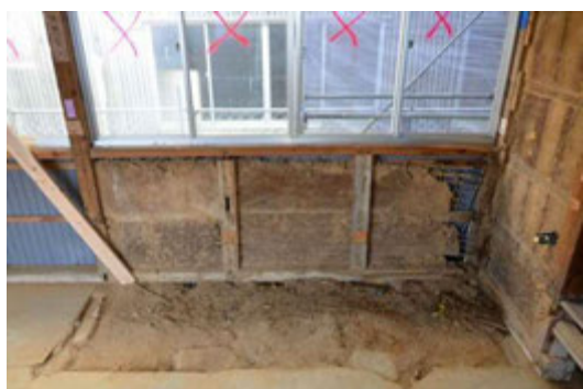
写真 4-27 当初物入・押入の下部土壁
