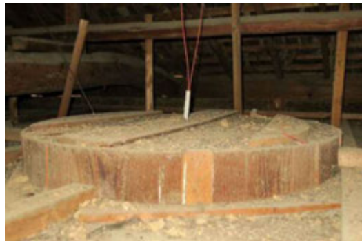
写真 4-15 漆喰飾り小屋裏内の様子
