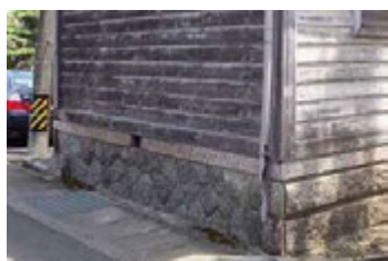
写真 2-2 縁石、間知石積
