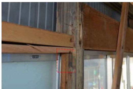
写真 4-24 高窓敷居痕跡
