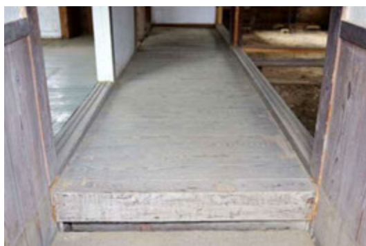
写真 4-3 東廊下 建設当初の床板と框
