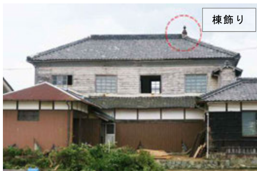
写真 4-10 本館北面外観
