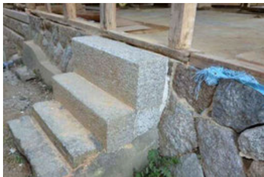
写真 4-26 石階段と土台
