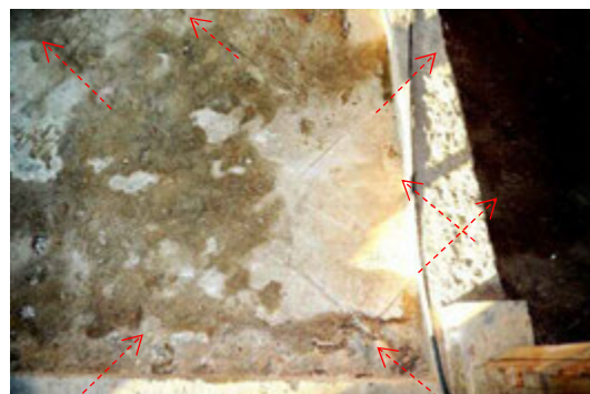
写真 4-2 四半目地の状況詳細
