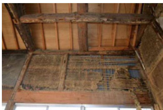
写真 4-28 当初物入・押入の上部土壁、柱、梁
