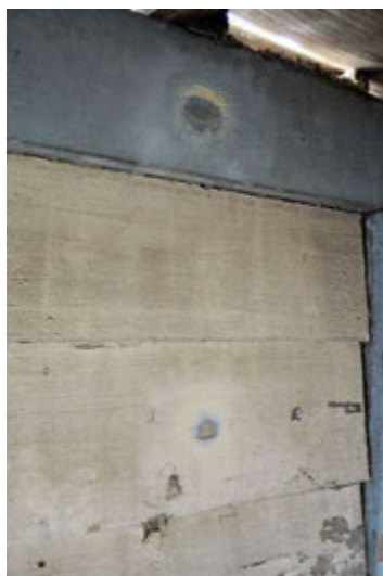
写真 3-1 来賓室棟外壁
