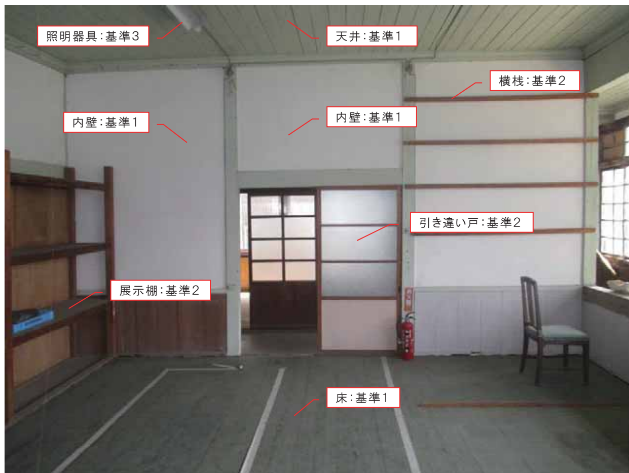
1階 事務室(東面)
