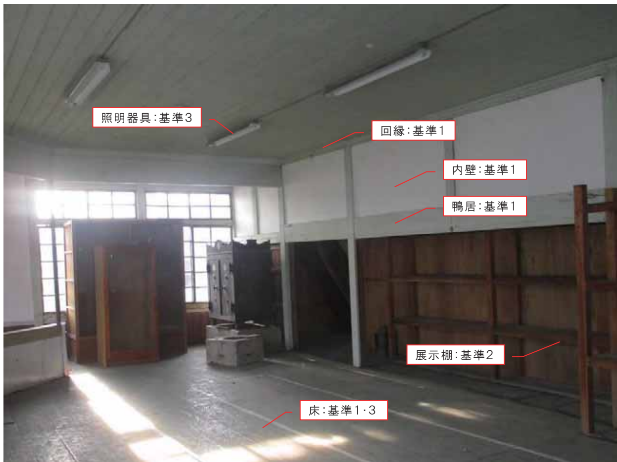
1階 事務室(北西面)
