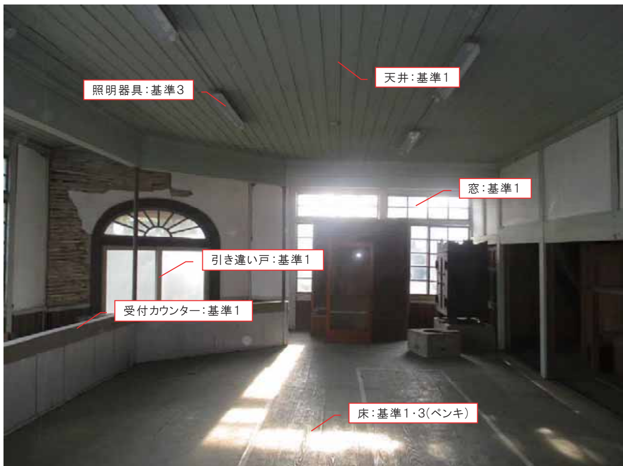
1階 事務室(西面)
