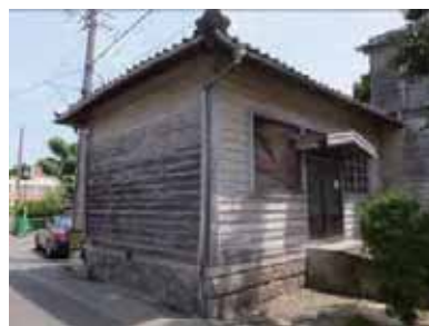
来賓室棟（西面）
