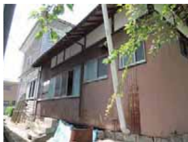
小使室棟（東面）
