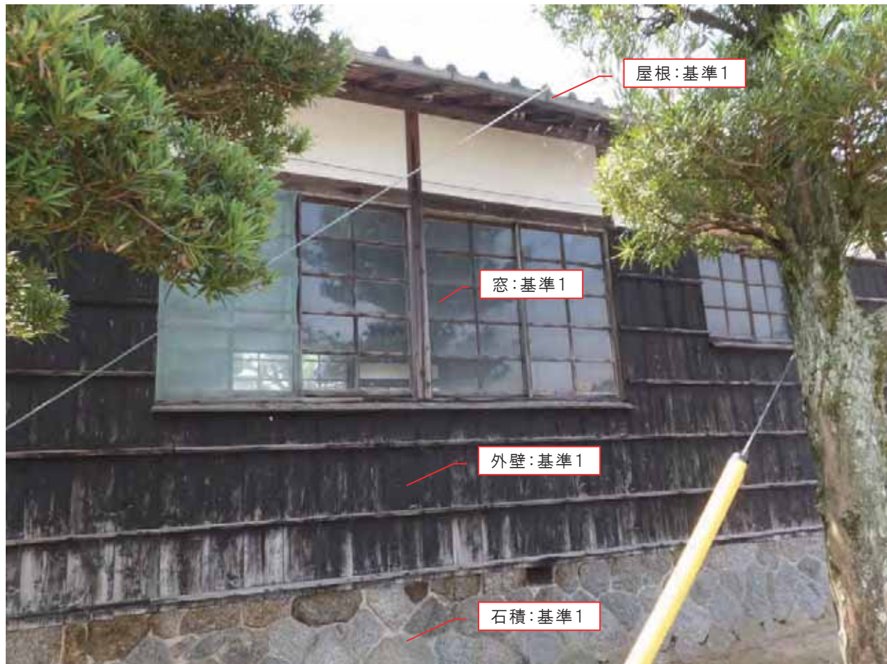
外観 来賓室(北面)
