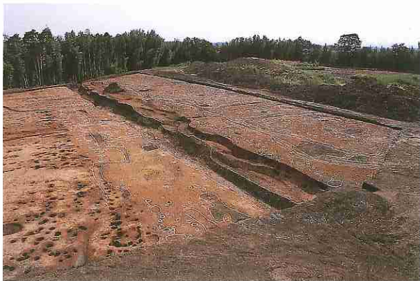
上野遺跡の堀と土塁(北西から)
