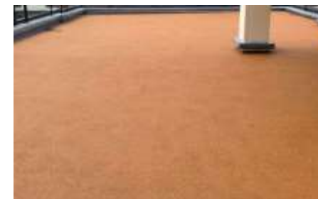
噴水部分を解体し、ゴムチップ などのやわらかい舗装
