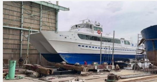
造船所での上架作業
