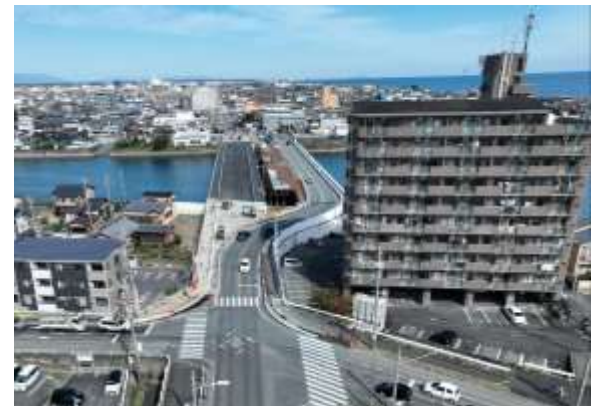
橋梁前後の取り付け
