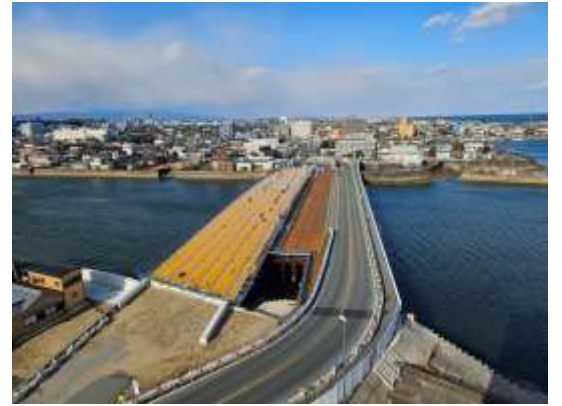
新橋上部工の床版工
