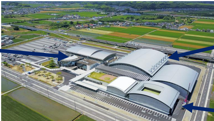
津市産業・スポーツセンター
