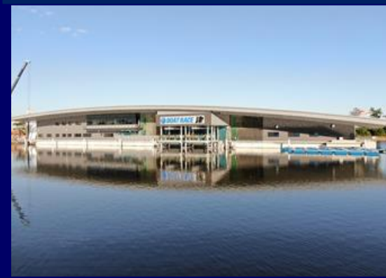
競技棟(R5.12完成)
