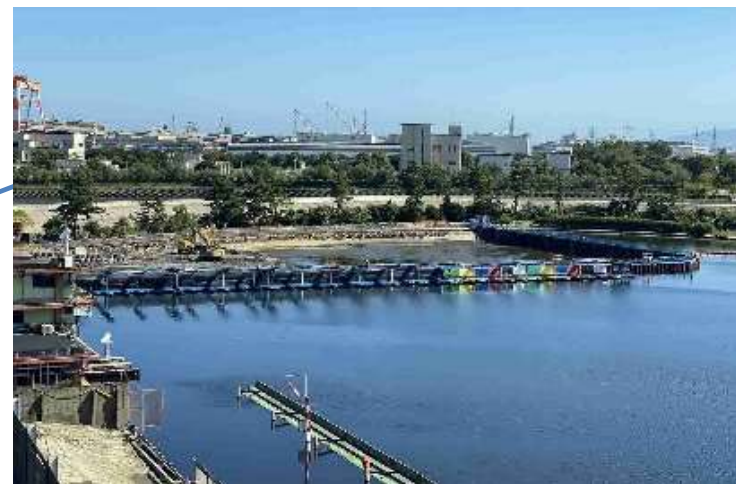
地盤改良工事
