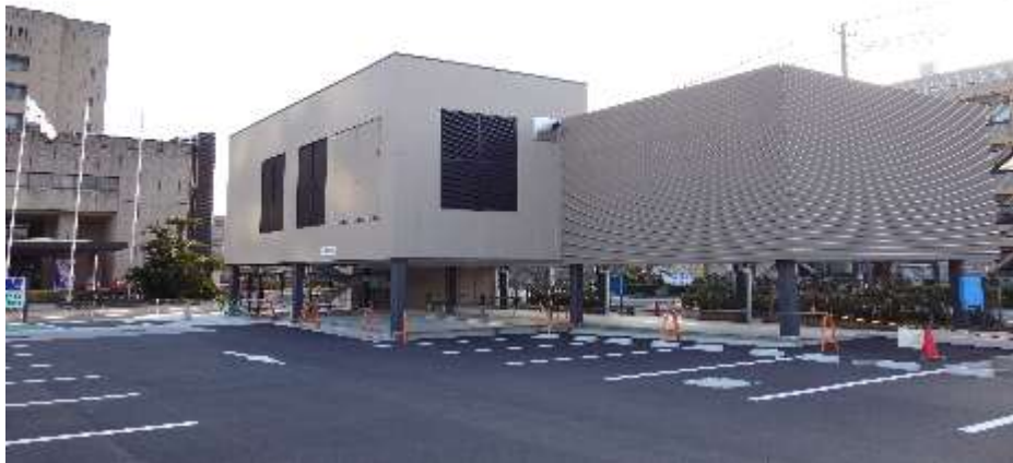
受変電設備 (キュービクル棟)
