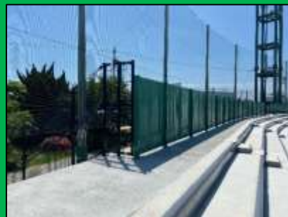
フェンス改修
