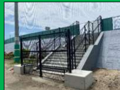
スタンド入口改修
