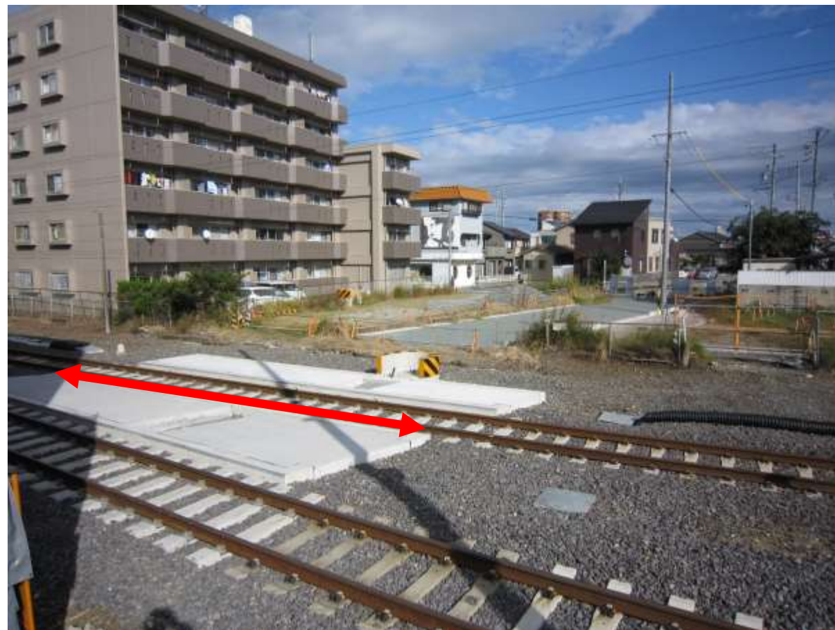
新踏切工事中
