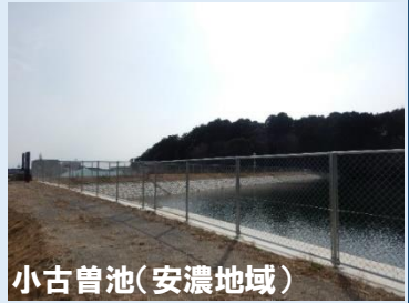
ため池(耐震改修)
