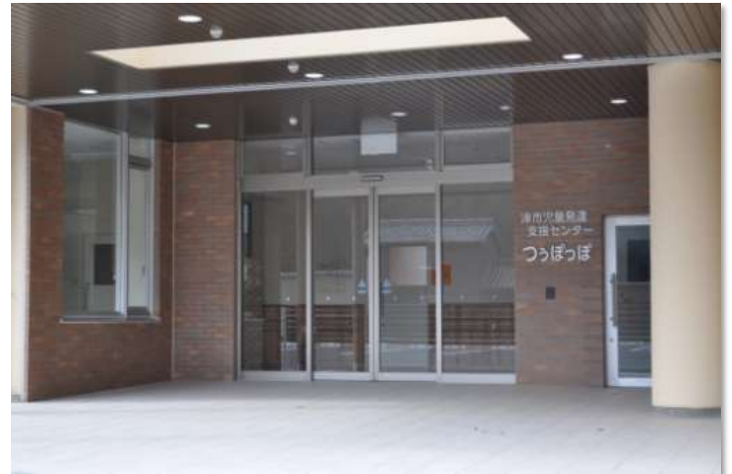
旧櫛形幼稚園舎を改修して整備
