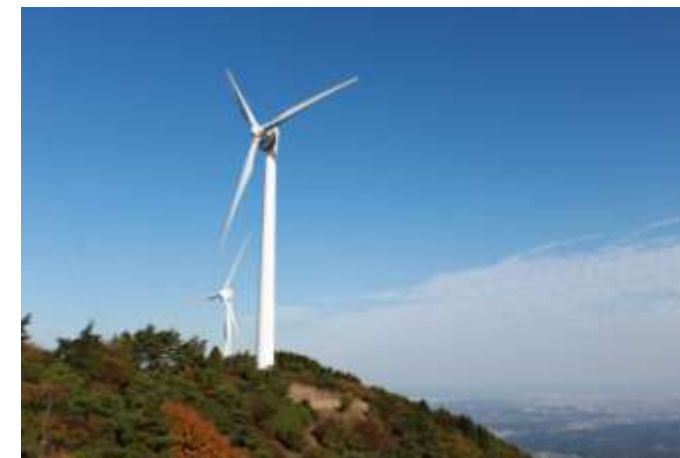
青山高原風力発電施設
